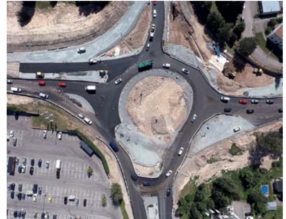
En drönarbild som visar utformningen av den ombyggda Grådarondellen. Bilden togs några veckor innan slutbesiktningen den 12 oktober. Foto Trafikverket.
