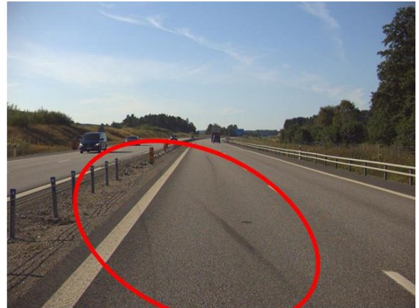
Figur 9 Trafikfarlig sättningskada pga. otillräcklig grundförstärkning av lös lera. Foto: S Hedlöf.
