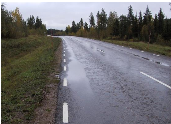
Figur 11 Trafiklastberoende deformation i hjulspår på väg med smal vägren. Bildkälla: ROADEX.
