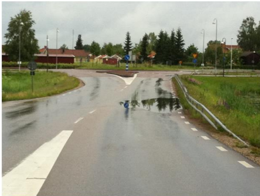
Figur 8 Snabb deformation 3 mm/år pga. avrinningshinder. Foto: J. Granlund
