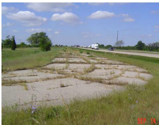
Figur 2 AASHO "Non-Traffic Loop 1" var i uselt skick i september 2005. Källa: TRB E-C 118.
