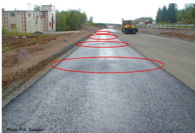
Figur 3 Vanligt byggfel kapar livslängden hos den blivande vägens asfaltbeläggning
