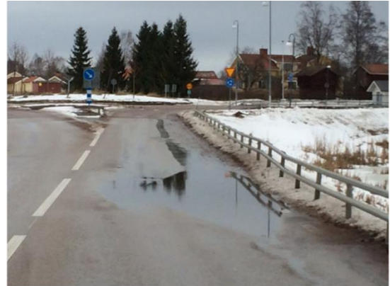
Figur 8 Snabb deformation 3 mm/år pga. avrinningshinder. Foto: J. Granlund
