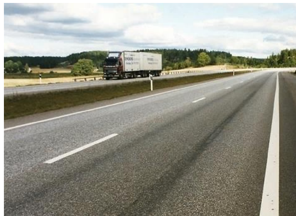
Figur 6 Avnötning orsakad av dubbade personbilsdäck. Bildkälla: ROADEX
