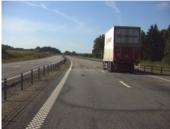
Figur 9 Trafikfarlig sättningskada pga. otillräcklig grundförstärkning av lös lera. Foto: S Hedlöf.
